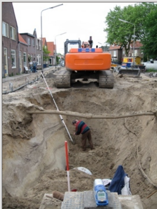
Velserveduinweg IJmuiden, rioolvervanging voorjaar 2006. Amateurarcheoloog Hans Steeman biedt de helpende hand bij het schoonmaken van de putwand. De donkere begroeiingslagen van voormalige landschappen tekenen zich af in het duinzand. Ter hoogte van Hans' hoofd bevinden zich de voormalige karrensporen.
